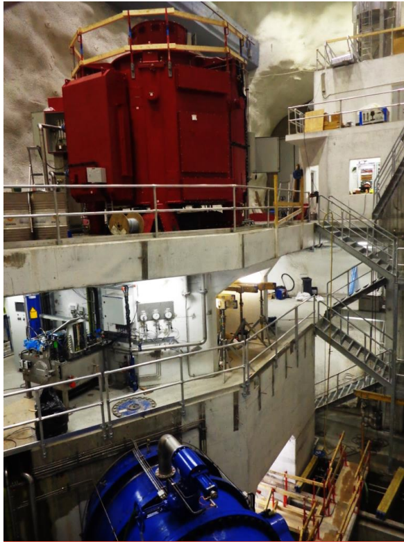
13.932MW Generators - KJENSVATN Project - Norway
