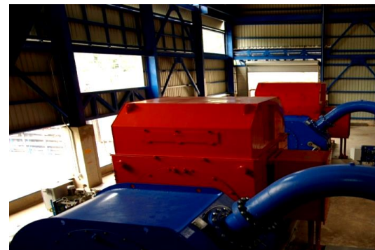
7.2MW Generator - PANTASMA - NICARAGUA
