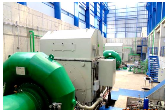
11.7MW Generator - CUBUJUQUI-COSTA RICA
